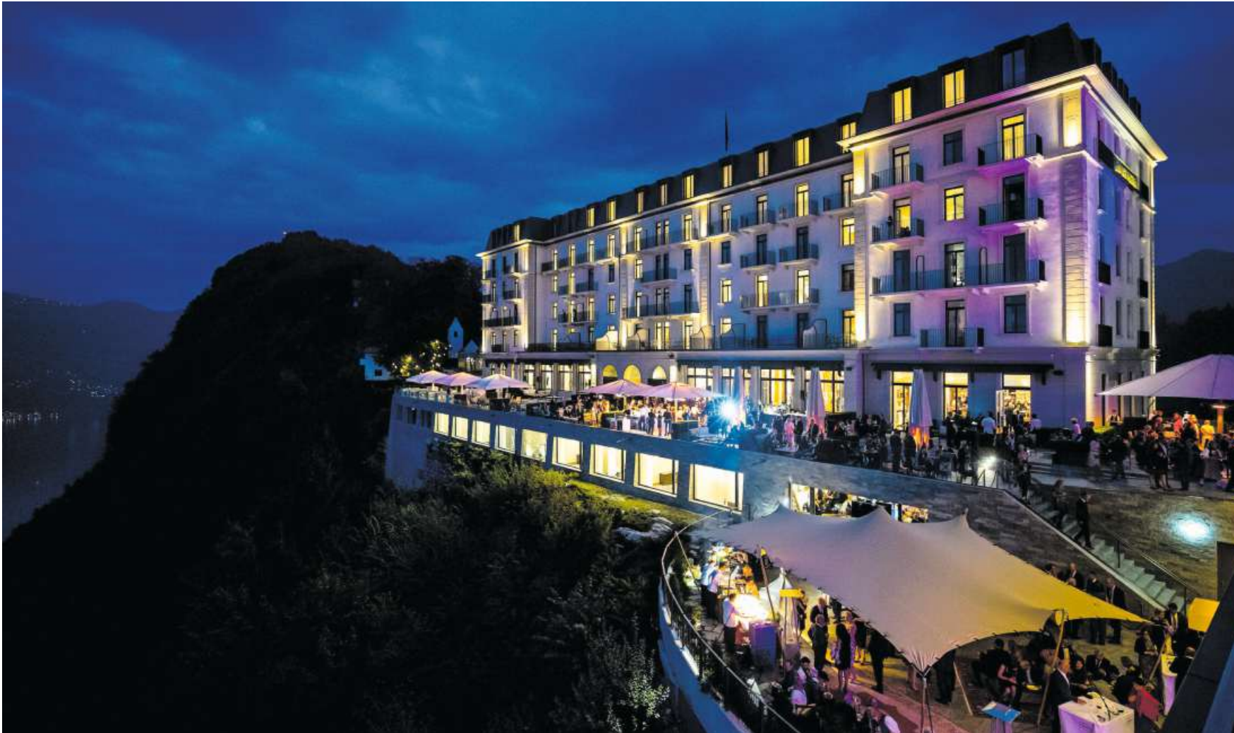
«Grand Opening» des Bürgenstocks: Über 700 Personen arbeiten in der Hotelanlage.
