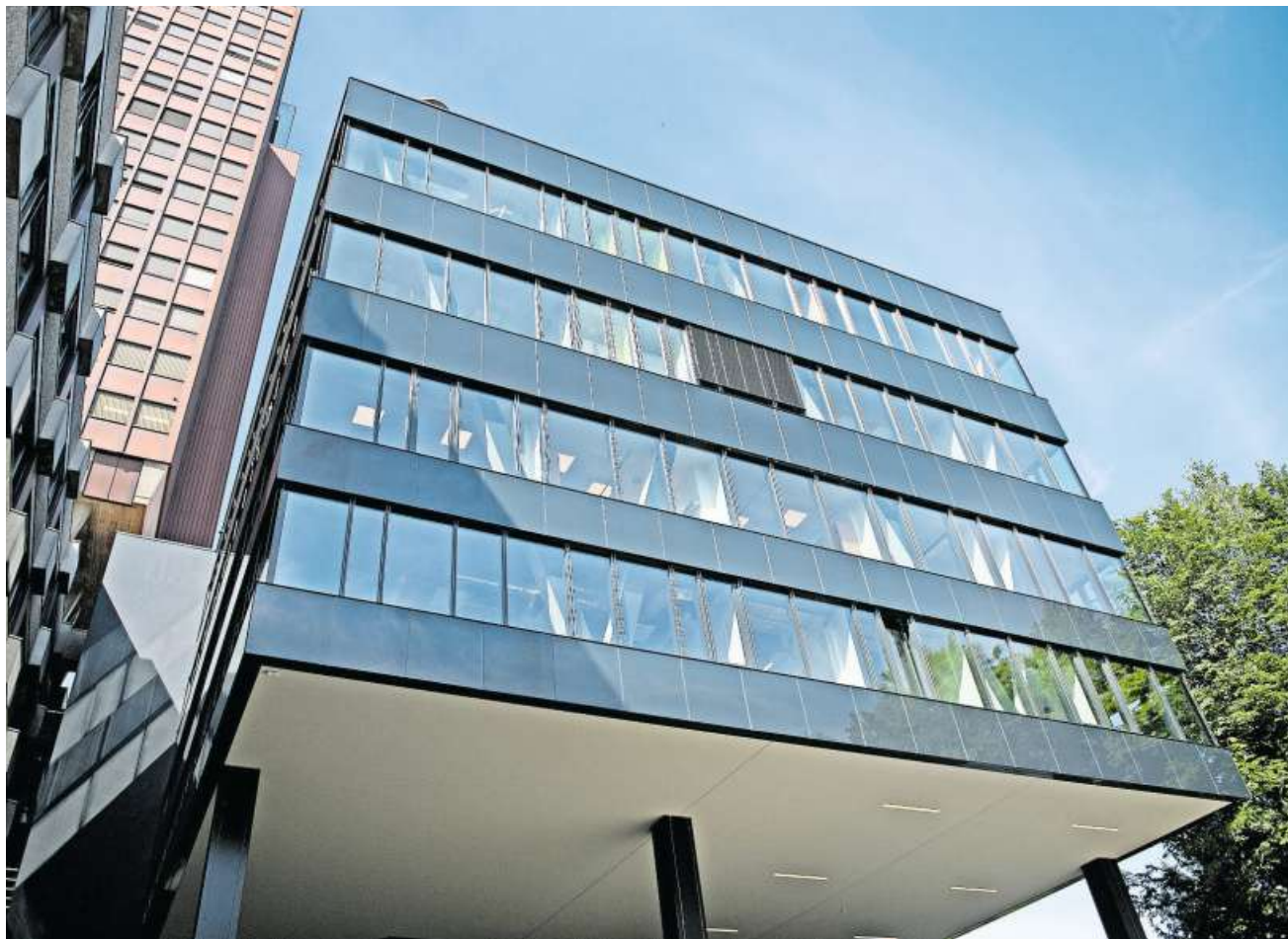
Das Kantonsspital ist der grösste Arbeitgeber in der Zentralschweiz. Im Bild das neue Notfallzentrum des Kantonsspitals Luzern.
