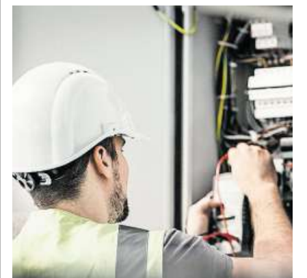
Installateure der CKW sind an 40 Zentralschweizer Standorten tätig. Bild: PD
